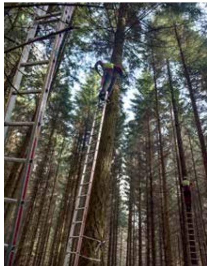
Ziehen Sie das bereitgestellte Klappleiterteil mit einem Gurt nach oben und stecken es dann in das lange Element.
